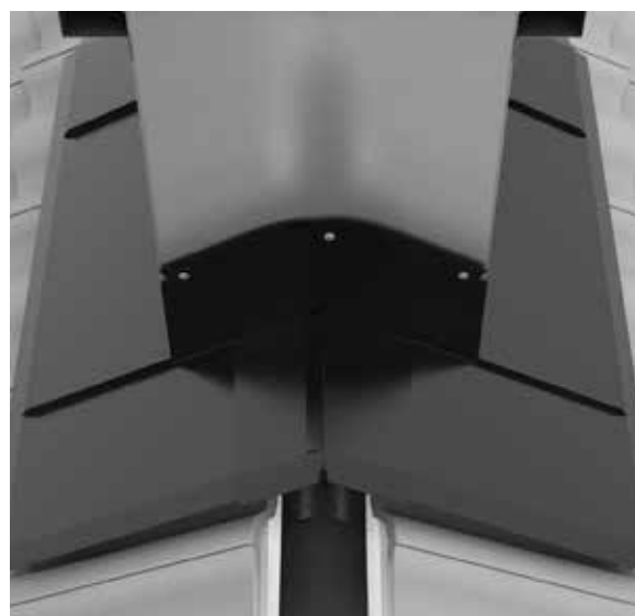
18. Montera de ställbara nockarna med 4 st LP-skruv 4,8×20 plus 4 st montageskruv 4,2×25.
